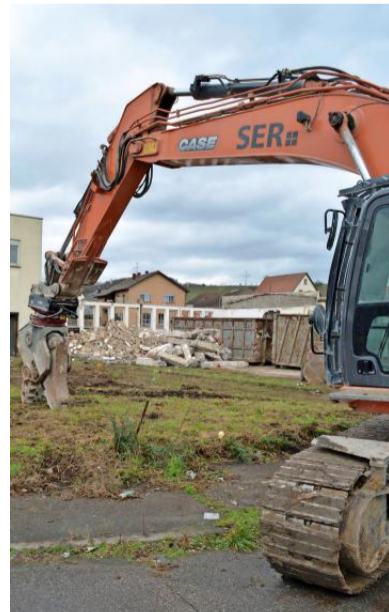
Bagger brechen die ehemaligen Verwaltungsgebäude der Gurkenfabrik ab.
